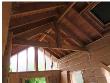
Isolation des murs intérieurs
