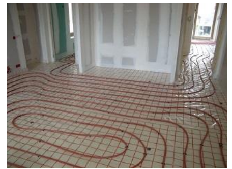
Pose d'un plancher chauffant
