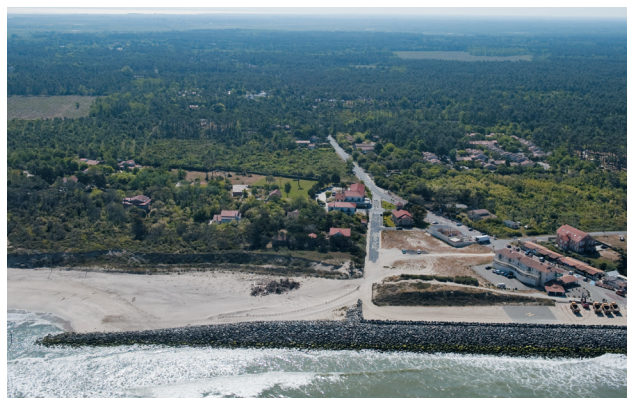
La Ville de Soulac-sur-Mer (Nouvelle-Aquitaine) a construit une digue pour protéger la plage et les habitations de l'érosion.
