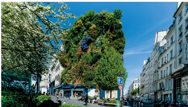
La végétalisation peut s'appliquer à des bâtiments existants, comme cette façade sans fenêtre à Paris qui compte 7 600 plantes et 237 espèces.
