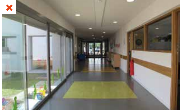
Plancher chauffant traditionnel en fonctionnement lors d'une journée ensoleillée. Les apports solaires vont se cumuler aux calories diffusées par le plancher et créer une surchauffe. De plus, même si le chauffage est coupé en début de matinée, le plancher reste trop chaud pour pouvoir valoriser de façon optimale les apports solaires. ©AQC
