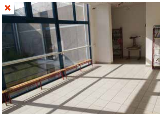
Exposition importante aux rayons solaires à cause de la grande surface vitrée orientée sud et sans protection solaire. Cette exposition est à l'origine des surchauffes en mi-saison et en été. ©AQC
