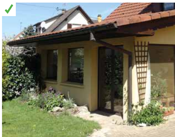
Protection solaire correctement dimensionnée. ©AQC
