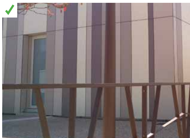
Pour améliorer le confort d'été, lors de la rénovation du bâtiment, les dimensions des ouvertures orientées ouest ont été réduites. ©AQC
