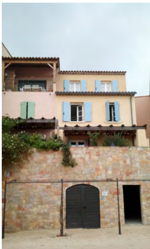
Remplacement des végétaux par des canisses © EnvirobotBDM
