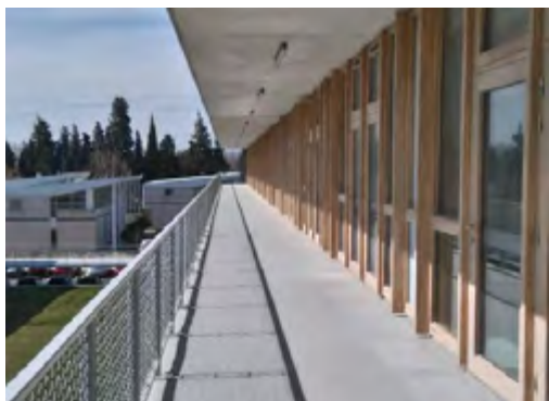
Une casquette de 2 mètres de profondeur pour ces bureaux dans le Vaucluse © EnvirobatBDM
