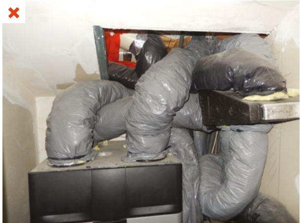
Des coudes et des écrasements de gaines souples sont présents à proximité immédiate de la CTA ce qui engendre des pertes de charges importantes. ©AQC
