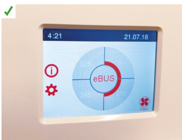
L'écran permet la remontée d'information en direct de l'état du filtre et avertit quand le changement doit s'effectuer. ©AQC
