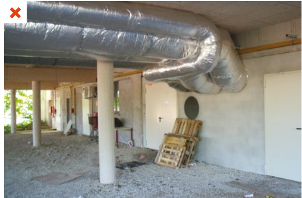
L'échangeur de la double flux est positionné en extérieur et impose des longueurs de gaine hors volume chauffé importantes. Le calorifugeage même performant ne permet pas de compenser les pertes thermiques. ©AQC
