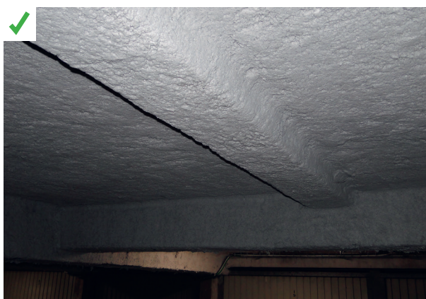
Les poutres en béton de ce garage ont été isolées sur toutes leurs faces (procédé de projection de laine minérale avec liants). ©AQC
