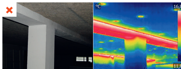
Les poutres en béton du sous-sol n'ont pas été isolées (procédé de panneaux rapportés sous dalle). Visualisation des déperditions engendrées à l'aide d'une caméra thermique (Note : les 2 images ont été prises sur le même site à des moments différents). ©AQC
