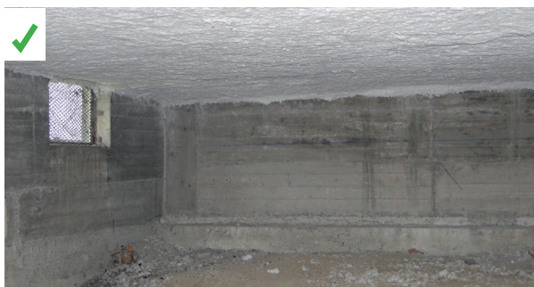
Dans ce vide sanitaire d'immeuble, le plancher bas a été isolé en sous-face par une projection d'isolant minéral, tout en conservant la ventilation traversante existante. ©AQC
