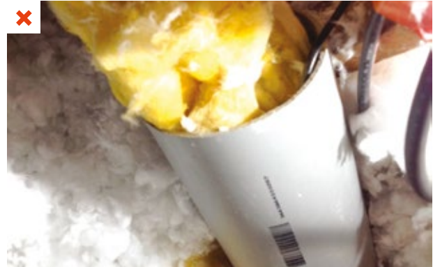
Des tubes en PVC remplis de laine de verre font office de protection des spots encastrés. ©AQQC
