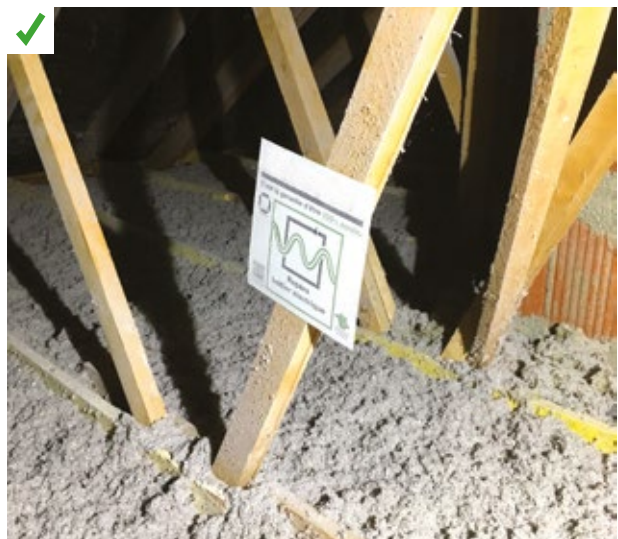
Une affiche de repérage, fournie par le fabricant, a été placée sur un élément de charpente pour repérer un boîtier électrique étanche situé à l'aplomb. ©AQC
