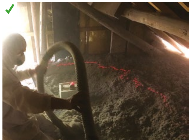
La hauteur d'isolant à souffler est repérée à l'aide d'un laser. Lorsque le faisceau se révèle à la surface de l'isolant, la hauteur est atteinte. ©AQC
