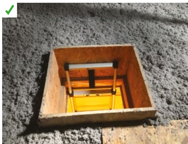
L'isolant soufflé est contenu au niveau de la trappe par un coffrage périphérique rigide. ©AQC
