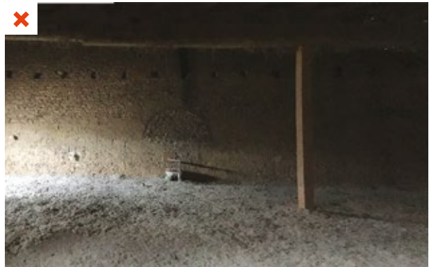
Des gaines et des boîtes de dérivation sécurisées se trouvent sous les 40 centimètres d'isolant soufflé. Il est impossible de les repérer en l'état. ©AQC
