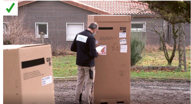
Les équipements et leurs caractéristiques techniques sont contrôlés lors de la réception sur le chantier avant l'installation. ©AQC
