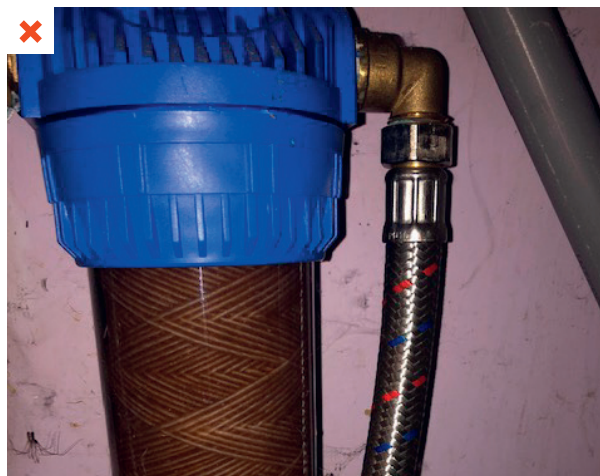
La cartouche jetable du filtre est saturée, car elle n'a pas été changée et a accumulé les particules en suspension dans l'eau.
