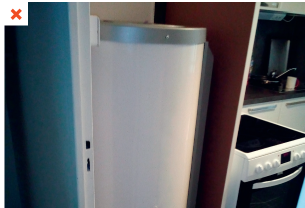
Le CET a été installé avant la mise en œuvre d'une paroi sèche en cuisine. La distance entre les deux éléments s'avère insuffisante pour permettre le contrôle visuel et l'entretien de la partie hydraulique. ©AQC
