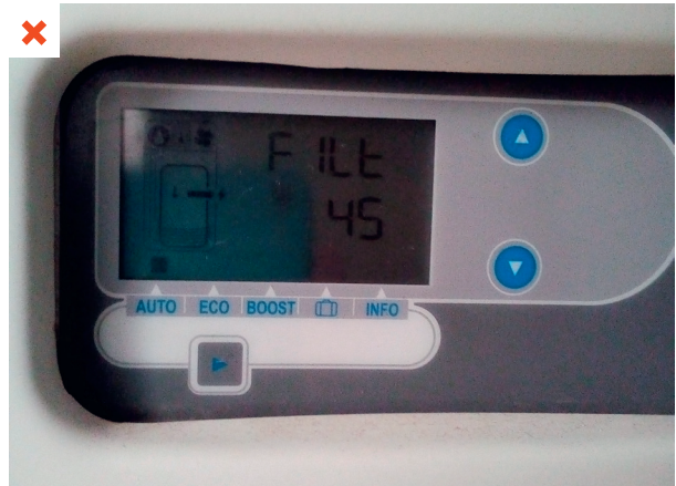
Le panneau d'affichage montre la saturation du filtre de la pompe à chaleur avec l'erreur « FILT ». Aucune intervention n'est prévue ni programmée. ©AQC
