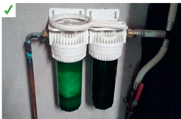
Mise en place d'un filtre à microparticules en amont du ballon d'eau chaude sanitaire. ©AQC
