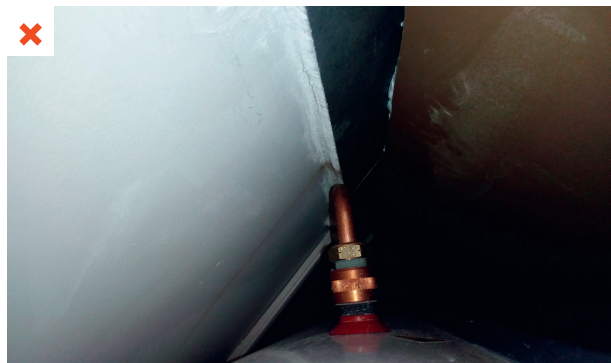
Absence de mitigeur thermostatique à la sortie du CET. Aucun autre mitigeur n'est présent entre la production et le point de puisage. Le risque de brûlure n'est pas contrôlé. ©AQC
