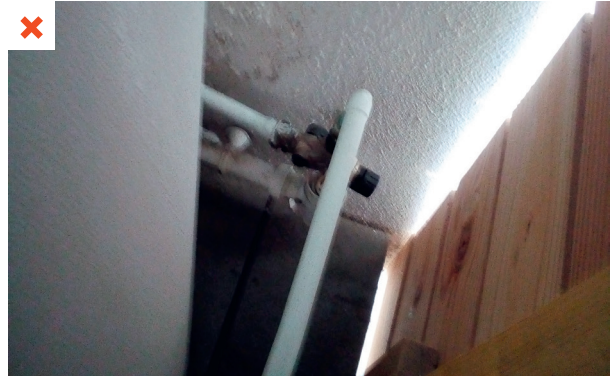
Le groupe de sécurité, placé en hauteur, est très difficilement atteignable. Cela ne favorise pas sa manipulation. ©AQC
