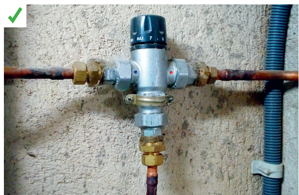
Un mitigeur thermostatique a été installé en sortie de ballon suite à des relevés de température supérieurs à la réglementation aux points de puisage. Il est réglé à 45 °C à la sortie du chauffe-eau à proximité des points de puisage. Un calorifugeage des réseaux est souhaité. ©AQC
