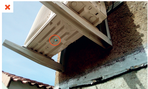
Les condensats de l'unité extérieure du CET bibloc s'écoulent librement au pied du mur, ce qui peut provoquer des dégradations dans le bâti à long terme. ©AQC
