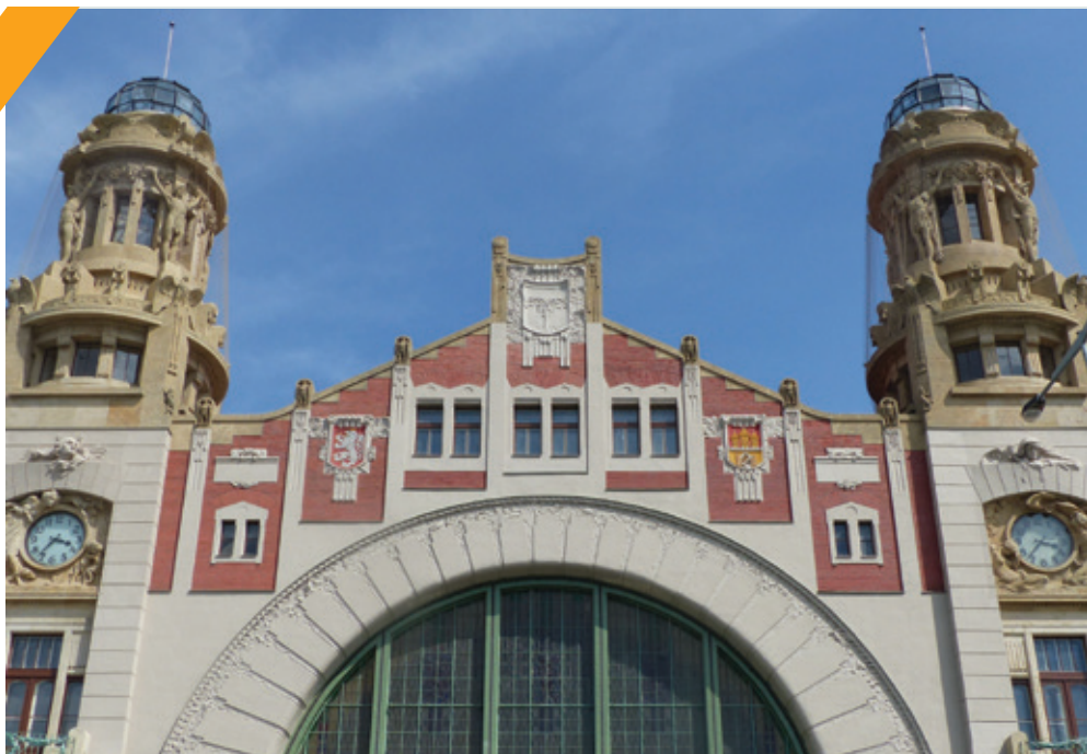
Bâtiment Fanta de la gare de Prague.
