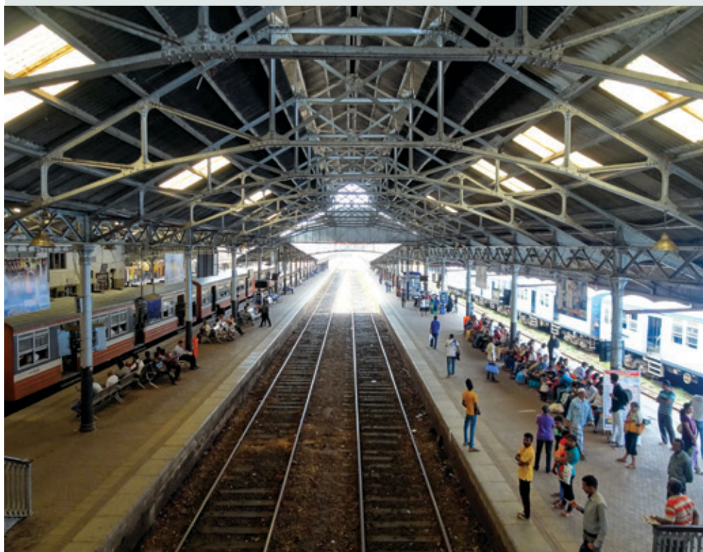
Le shed de la gare historique de Colombo.
