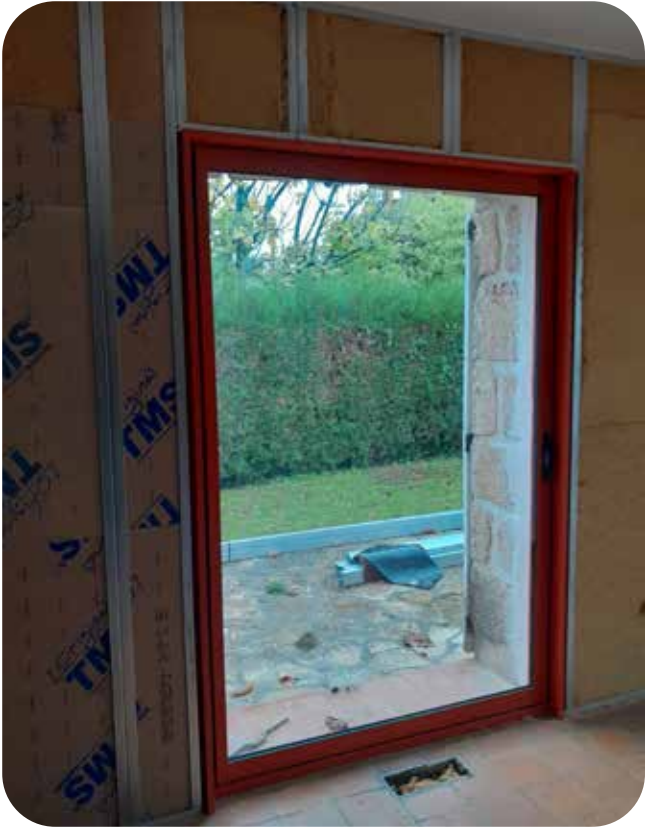
Isolation par l'intérieur en laine de bois
