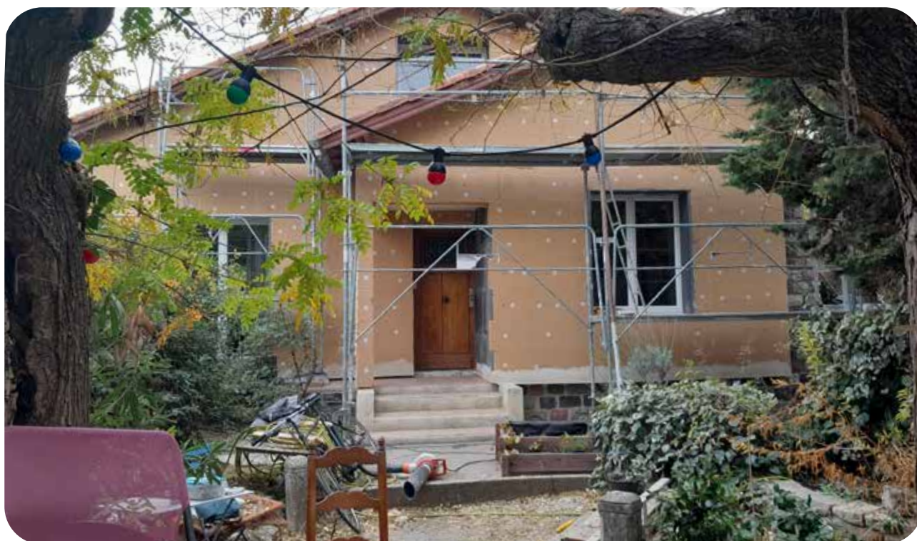
Chantier d'isolation par l'extérieur en fibre de bois
